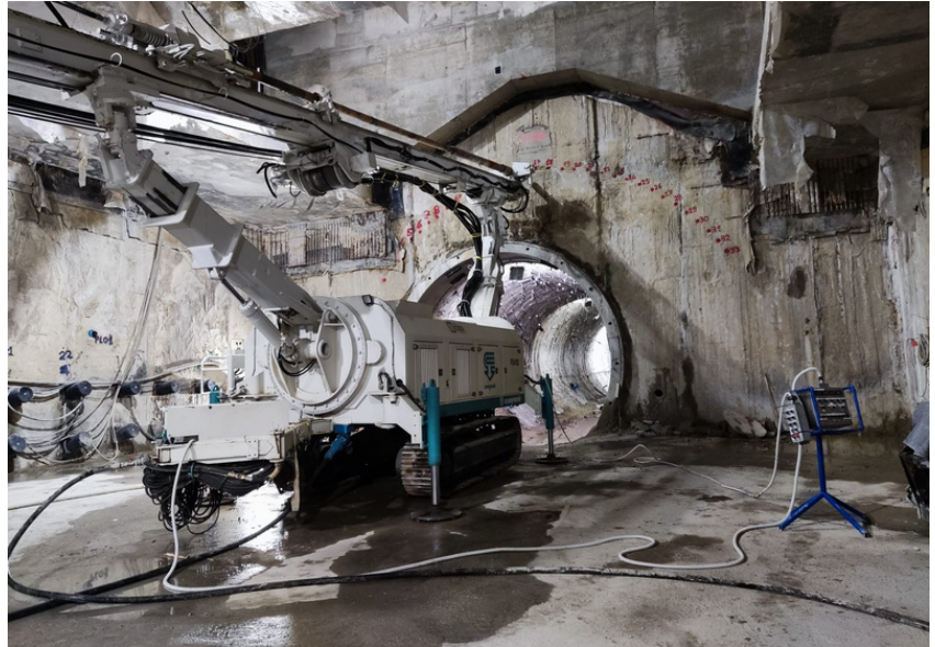
Cantiere Fori Imperiali - Binario Dispari lato Amba Aradam - consolidamento fronte di scavo
