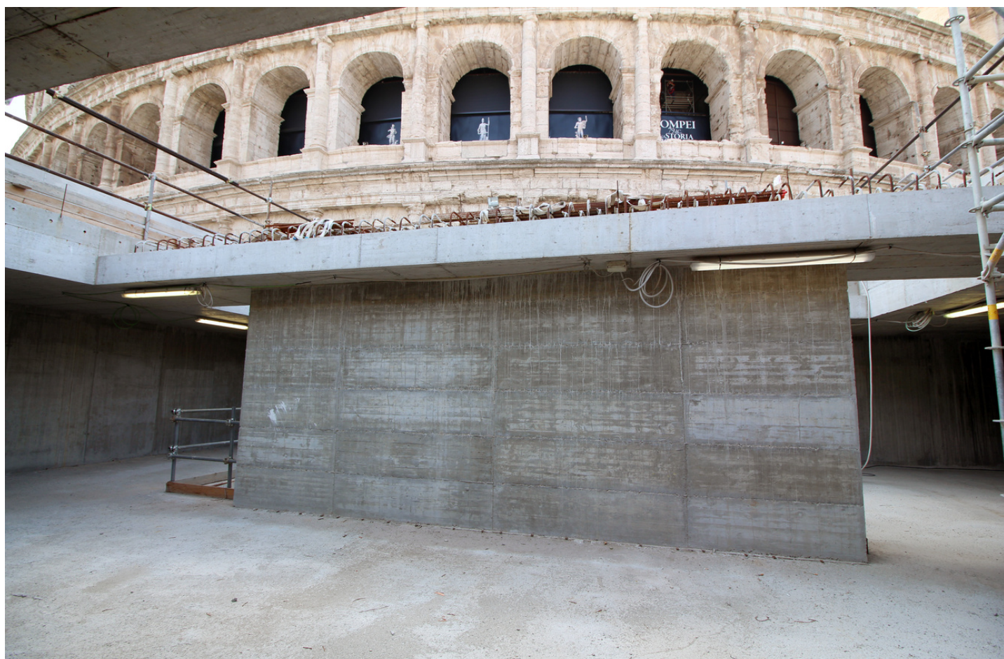
Cantiere Fori Imperiali - Pozzo Colosseo Interconnessione Linea B e C
