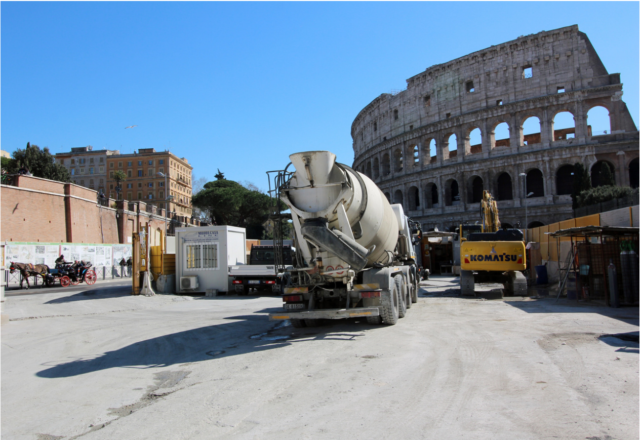
Cantiere stazione Fori Imperiali
