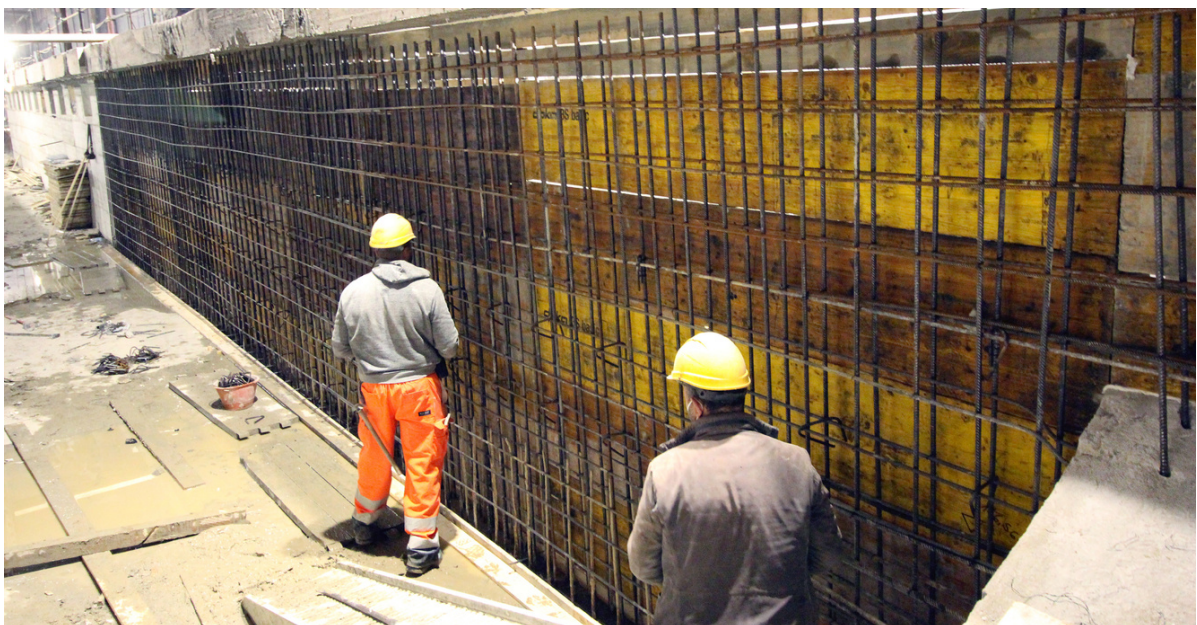
Cantiere Fori Imperiali - realizzazione setti di sostegno solaio banchina
