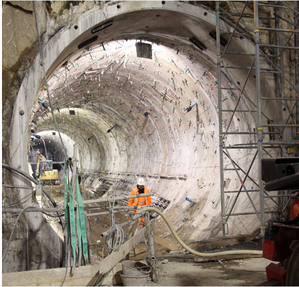
Cantiere Fori Imperiali - Binario Dispari lato Venezia - consolidamenti radiali
