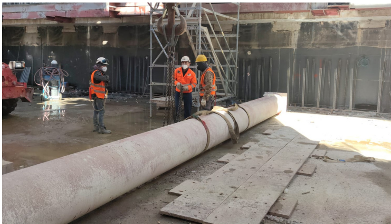
Stazione Amba Aradam / Ipponio - Area Corpo Stazione - smontaggio puntoni
